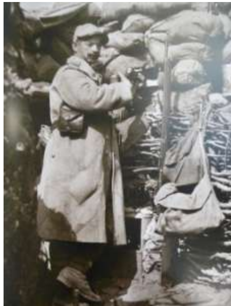
Sentinelle à la tranchée
