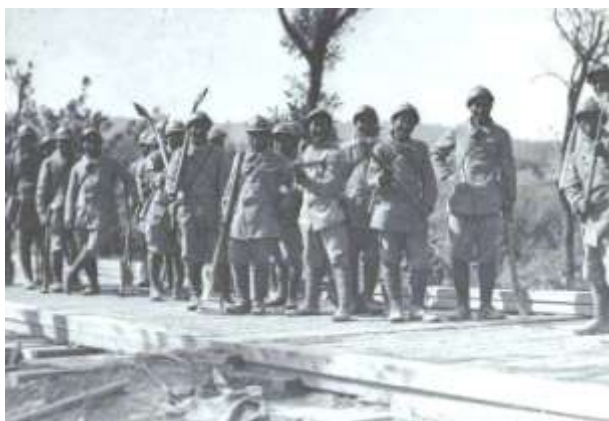
A Vailly en juin 1917, corvée de travailleurs annamites à la réfection d'un pont provisoire
